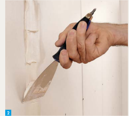
2. Mit dem Schraubgriffspachtel scharf abziehen.
