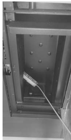
Fig. 36 - Reinigung mit Flaschenbürste
