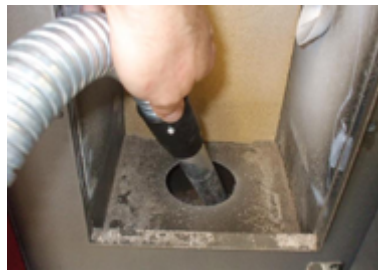
Fig. 39 - Reinigung Fach Brennschale
