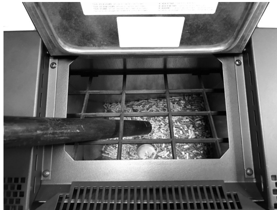
Fig. 32 - Reinigung Tank und Schnecke
