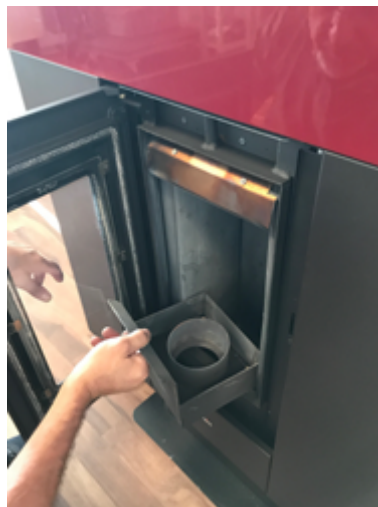
Fig. 36 - Reinigung Brennschale
